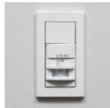
玄関のLED照明は人の熱と動きを感知して自動的に点灯・消灯する人感センサー付きとしました。夜間の帰宅時にも安心です。
