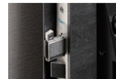
玄関扉の鍵をロックをした時にデッドボルト部分が鎌状に飛び出してストライク部分にガッチリとかみ合います。パルなどを使った強引なこじ開けに対して強く抵抗します。
