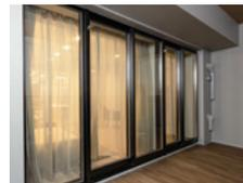
窓と窓の間に壁が無く、明るく開放感がある連窓サッシを採用しています。
